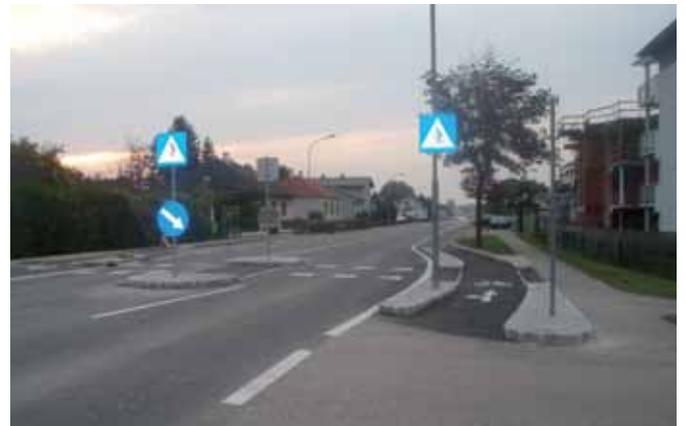
Um die Sicherheit der Radfahrer in Spillern weiter zu erhöhen wurde bei der Querungshilfe zur Kuttengasse die Fahrbahn verbreitert, um einen vom PKW-Verkehr abgetrennten Mehrzweckstreifen herstellen zu können.
