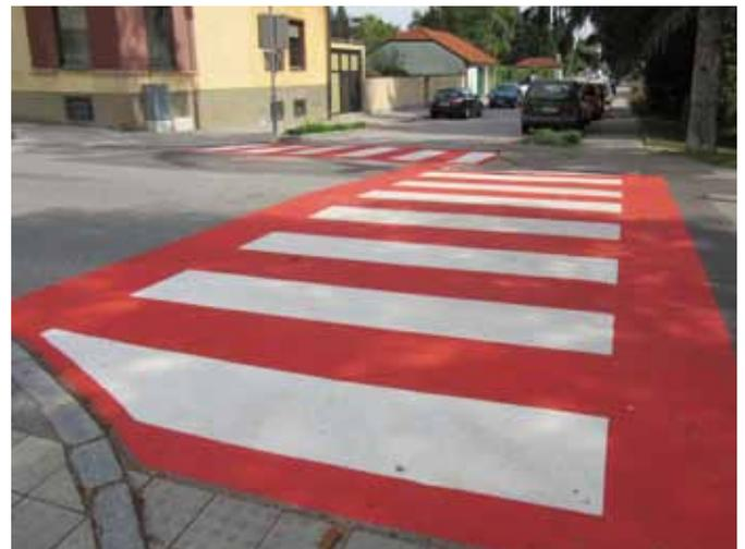
Zur besseren Erkennbarkeit werden die weißen Bodenmarkierungsbalken bei jenen Schutzwegen, welche auch oft als Schulwege benutzt werden, rot umrandet. Dadurch wird die Aufmerksamkeit der Fahrzeuglenkerinnen und Fahrzeuglenker deutlich erhöht.
